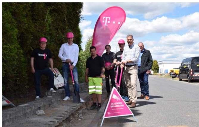
Gaben den Startschuss für den Glasfaser-Ausbau der Telekom in Zülpich und Hoven (v.l.): Gerd Wolter, Marco Lohmeier (beide Telekom), Silvio Franke (Franke Tiefbau), Beigeordneter Ottmar Voigt, Torsten Wilde (Telekom), Bürgermeister Ulf Hürtgen und Thomas Janßen (Telekom).
